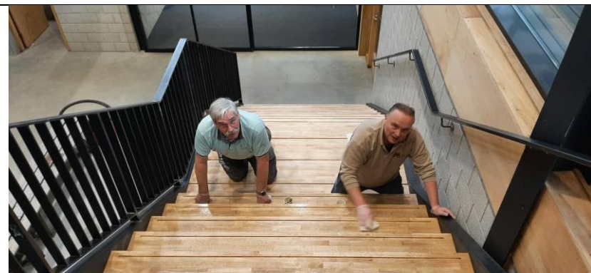
Trappen Binnenveld tijdelijk niet in gebruik
